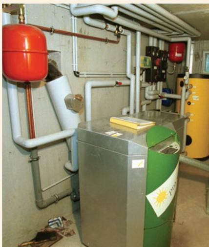
Abb. 6: Platzsparender Einbau einer Holzheizung
