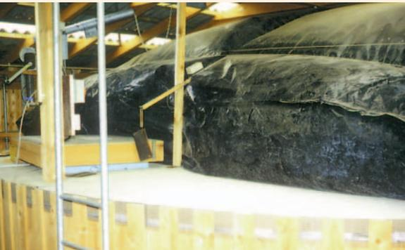
Abb. 6: Biogasfolienspeicher im belüfteten Dachraum über dem Faulbehälter
