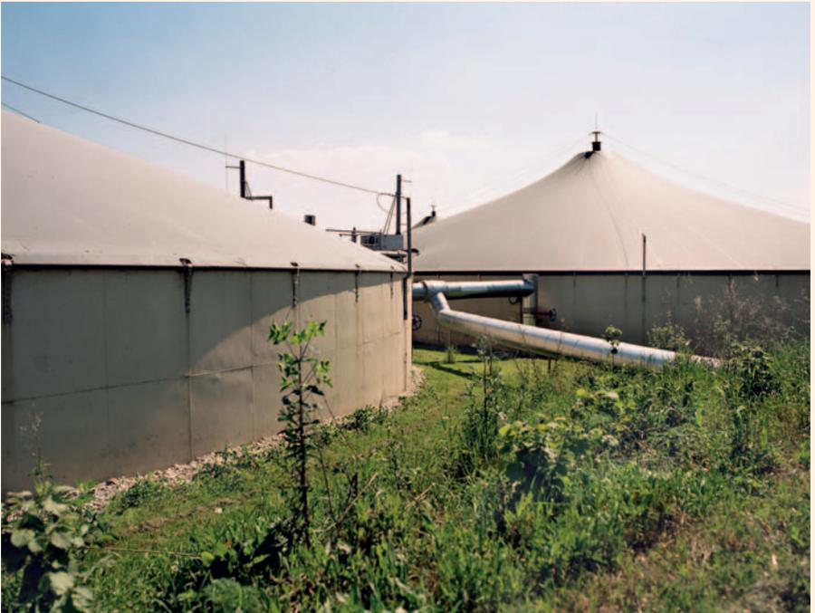
Abb. 5: Durchflussbiogasanlage mit Folienhaube als integrierter Gasspeicher
